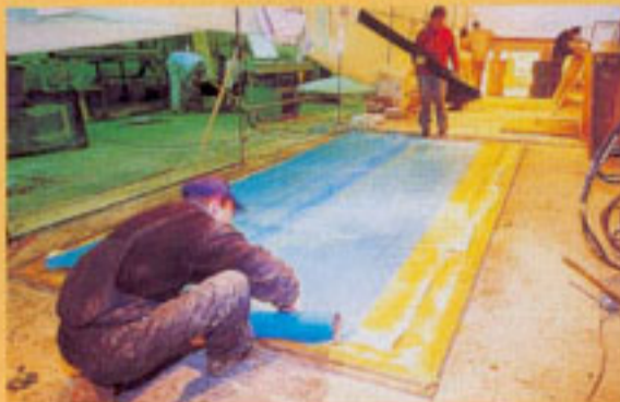
Sandwich sous vide: un procédé rapide et bien contrôlé appliqué aux cloisons et bientôt aux autres pièces, puis aux coques.
